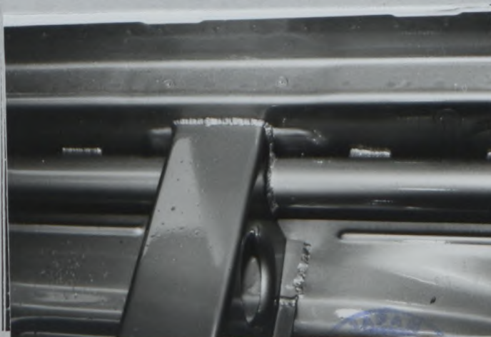
PHOTO N° 10/99 Floor sill ( RH )
